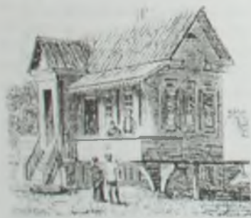
Постройки казаков низовых станиц
